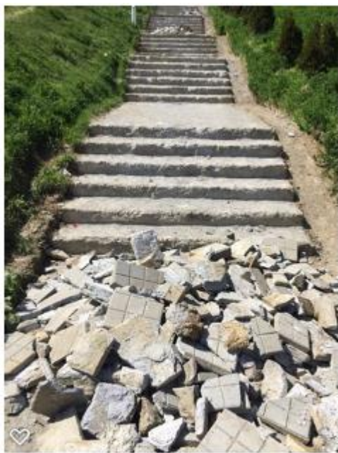
Demolimi i shkalleve
