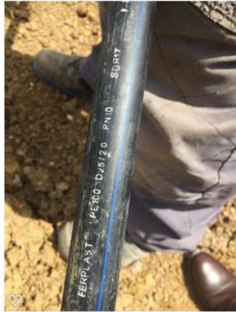
Gypi i furnizimit te ujit
