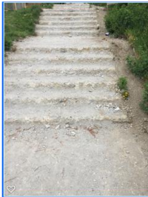
Shakallet pas Demolimit
