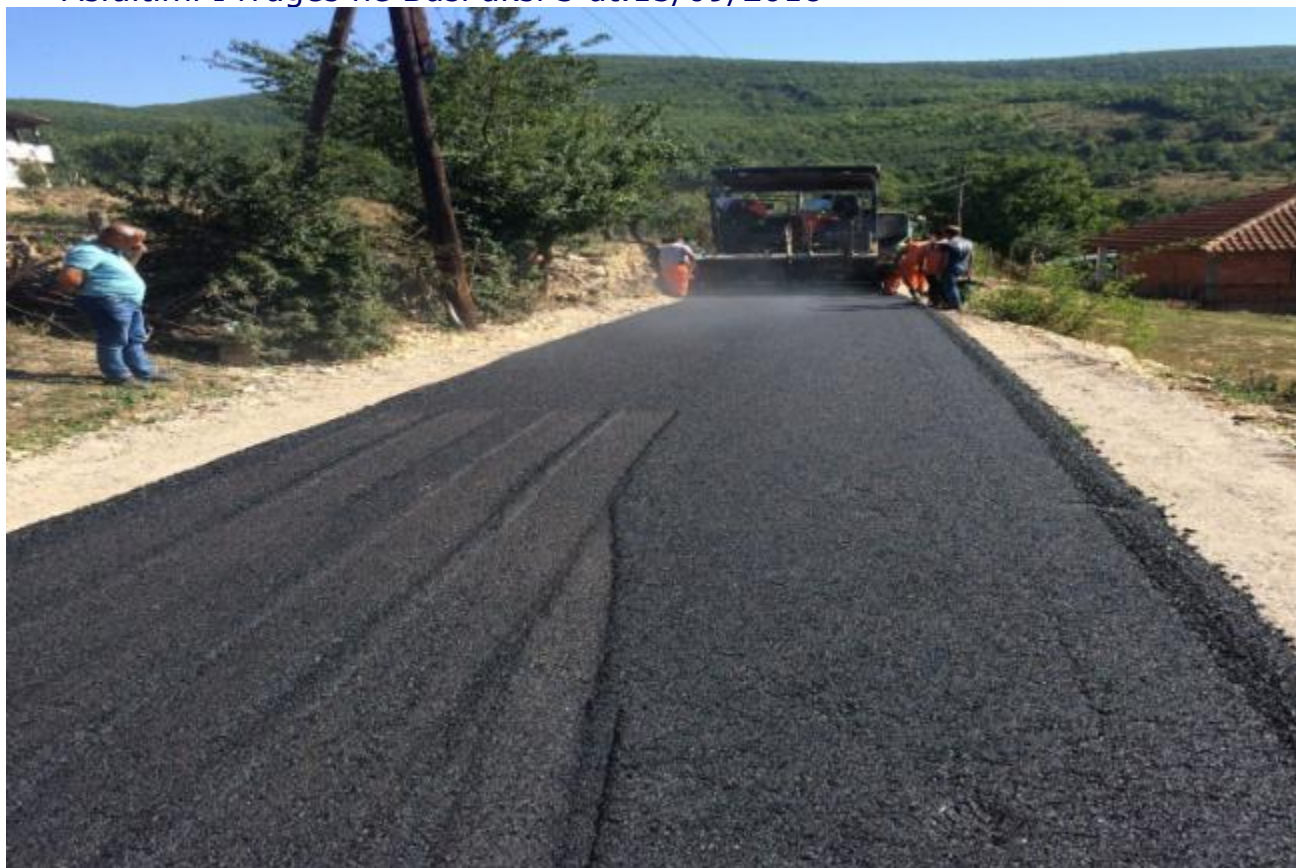
Asfaltimi I rrugës në Busi aksi 3 dt.13/09/2018
